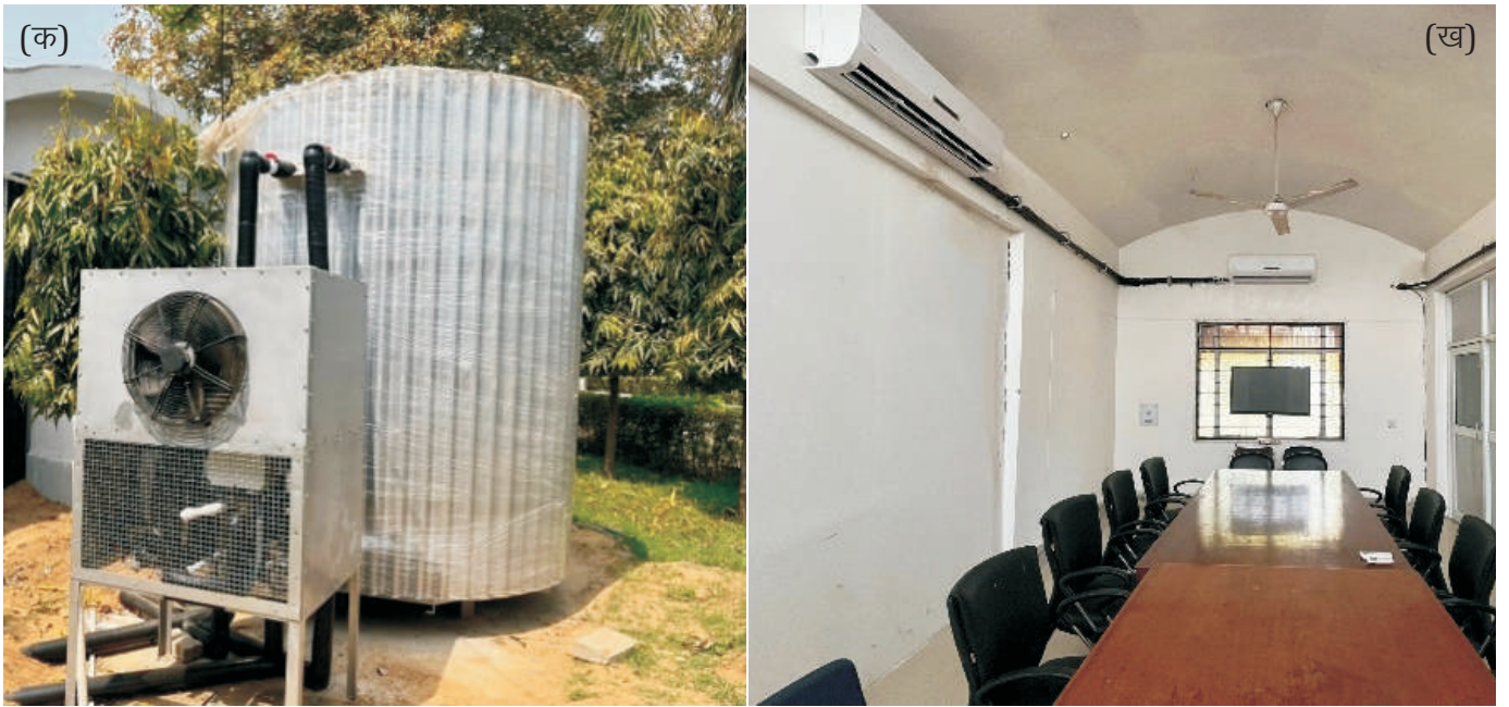
चित्र 2.9: (क) तापीय स्टोरेज टैंक के साथ हीट पंप आउटडोर यूनिट और (ख) हीट पंप की इनडोर यूनिट (3 टीआर क्षमता) की तस्वीर
