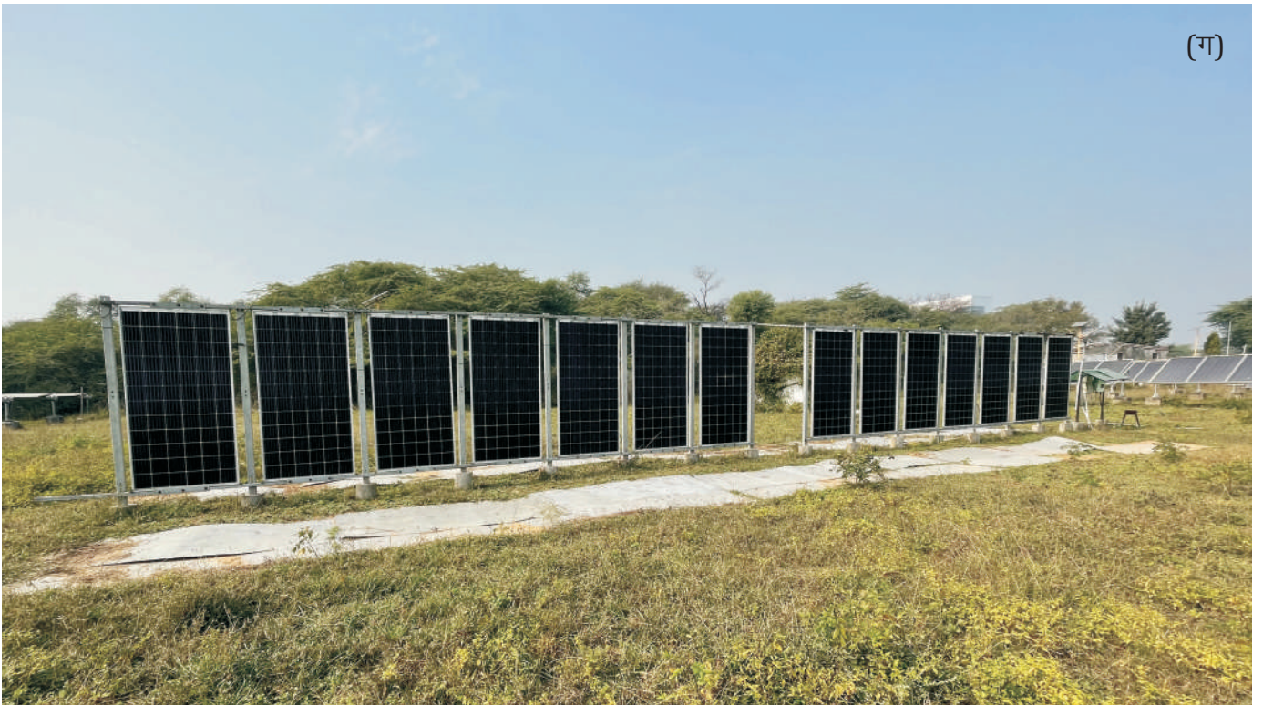
चित्र 2.4: सौर पीवी विद्युत संयंत्र की तस्वीर (क) अक्षांश झुकाव पर मोनो फेसियल (10 किलोवाट पीक), (ख) अक्षांश झुकाव (05 किलोवाट पीक) और (ग) लंबवत झुकाव (05 किलोवाट पीक) पर बाईफेसियल
