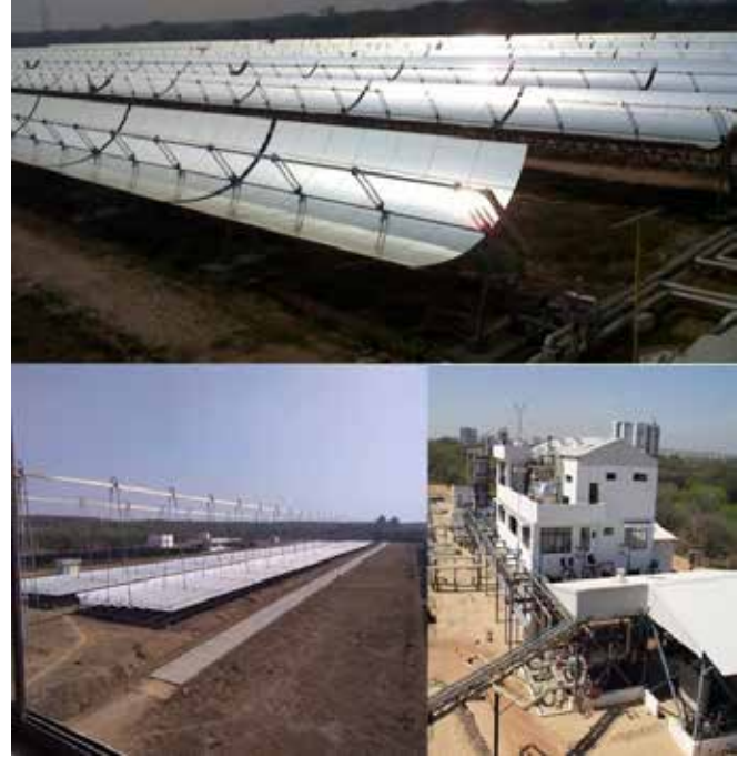
चित्र 5.1 : राष्ट्रीय सौर ऊर्जा संस्थान में एक मेगावॉट सौर तापीय विद्युत संयंत्र
