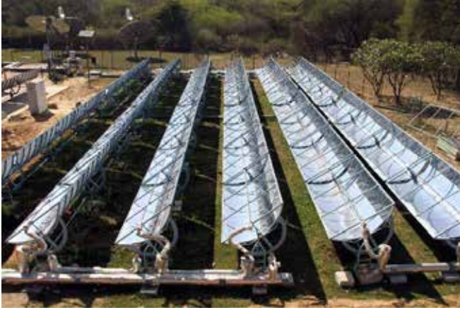
चित्र 5.5 : 100 किलोवॉट उच्च दक्षता तिगुना प्रभाव वाष्प अवशोषण प्रणाली
