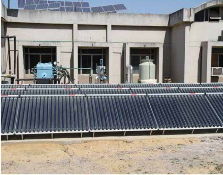
चित्र 5.7 : 5 किलोवॉट अवशोषण रेफ्रिजरेशन प्रणाली
