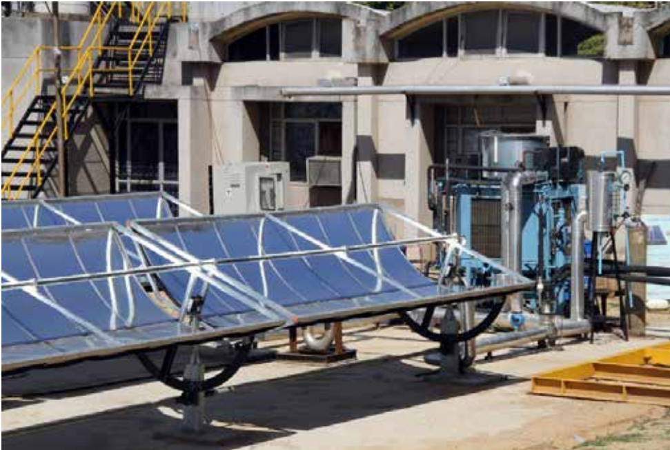
चित्र 5.6 : 15 किलोवॉट सौर अवशोषण प्रशीतन प्रणाली (एयर कूल्ड)
