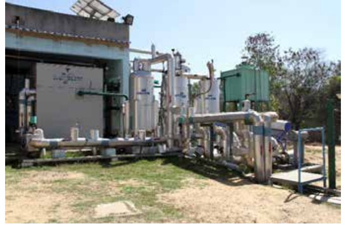
चित्र 5.5 : 100 किलोवॉट उच्च दक्षता तिगुना प्रभाव वाष्प अवशोषण प्रणाली
