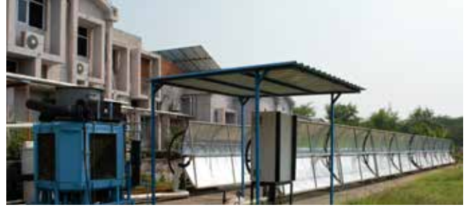
चित्र 5.3 : 15 किलोवॉट डबल प्रभाव वाष्प अवशोषण प्रणाली
