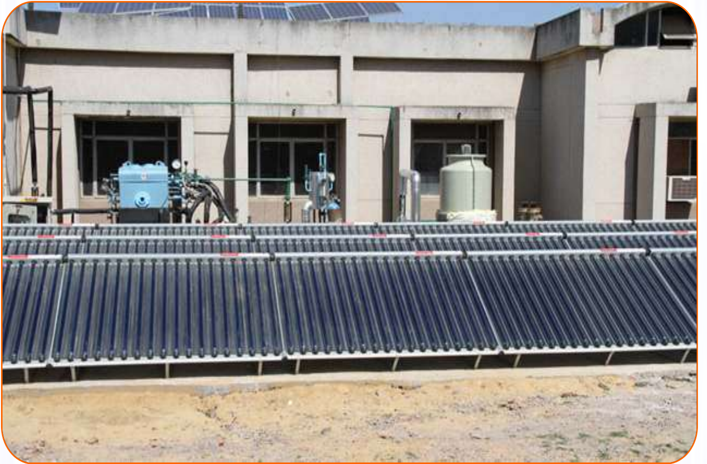
चित्र 3.7 : 5 किलोवॉट अवशोषण रेफ्रीजरेशन प्रणाली
