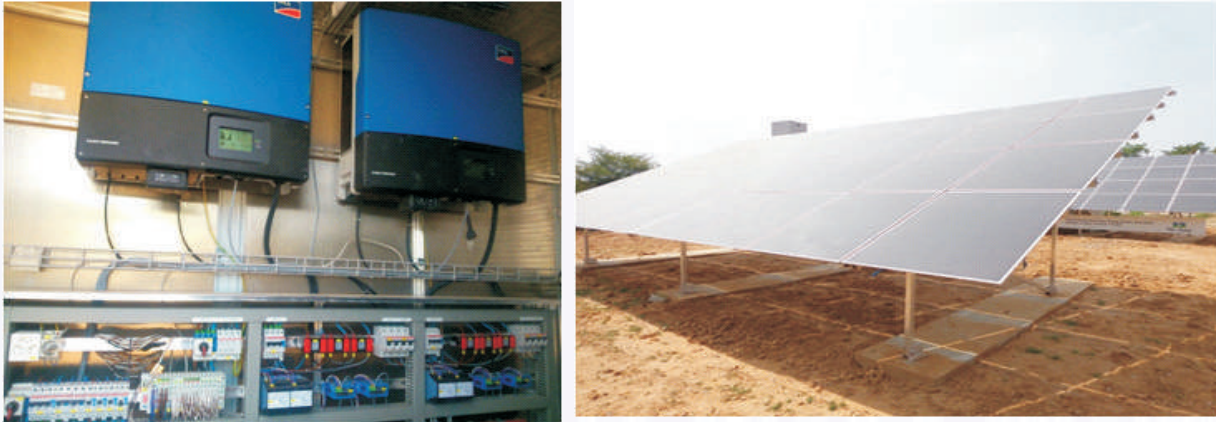
चित्र 6. नाइस में पतली फिल्म पीवी प्रौद्योगिकी परीक्षण बेड आधारित माइक्रो – मोर्फ एमएफसी और स्थल विशिष्ट उपयुक्त तीन पीवी प्रौद्योगिकियां
