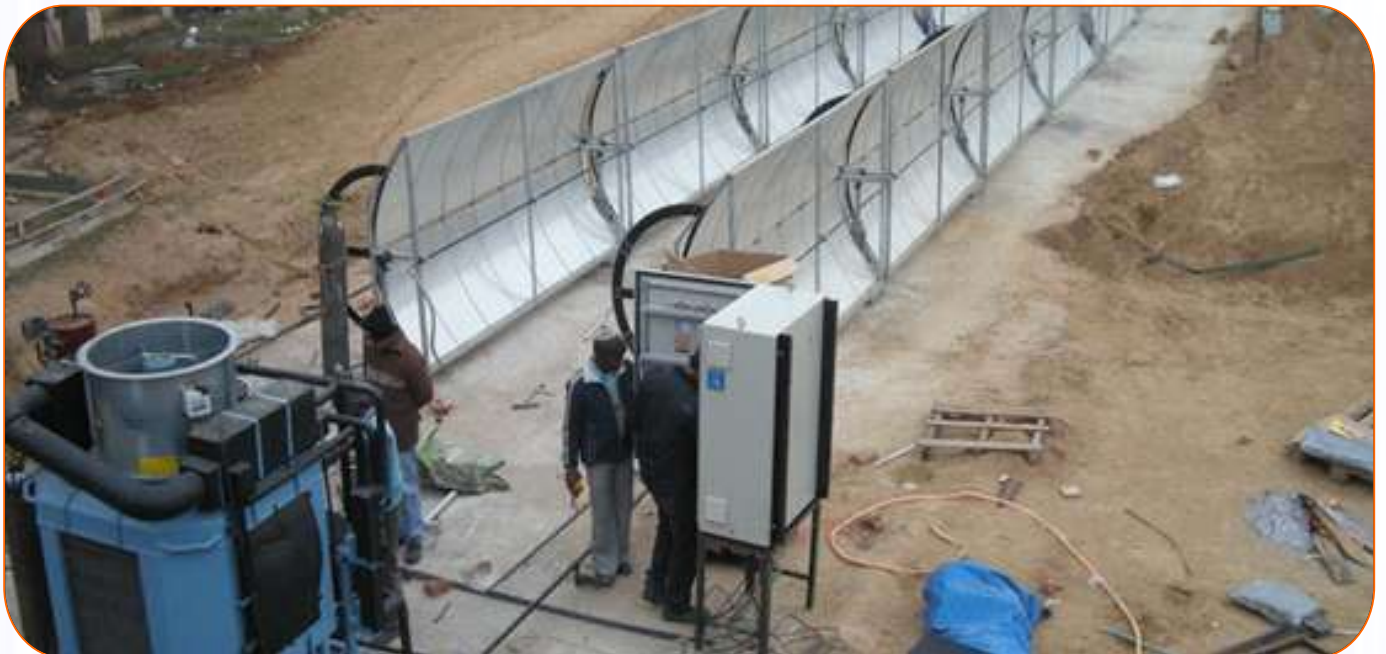
चित्र 3.6 : 15 किलोवॉट अवशोषण रेफ्रीजरेशन प्रणाली (वायु शीतन)
